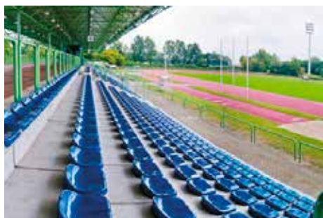
Ghế cố định trực tiếp trên nền bê tông.
