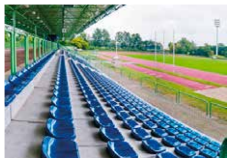
Ghế cố định trực tiếp trên nền bê tông
